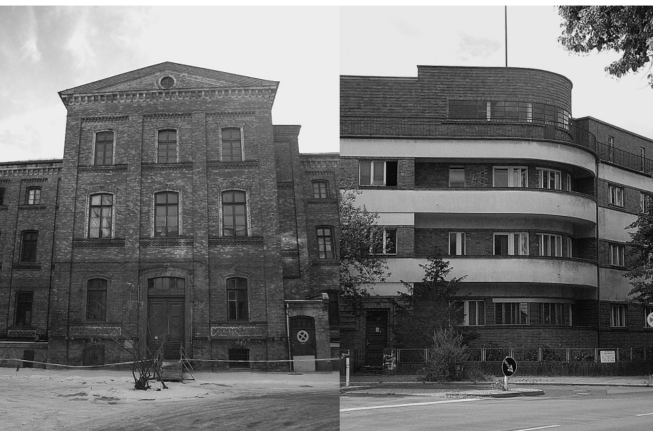
l: Berlin, Krankenhaus Auguststraße (1859–61), Eingangsfassade, Arch. E. Knoblauch/Berlin, hospital Auguststraße (1859–61), arch. E. Knoblauch, entrance façade (K. Kessler, 2008).
